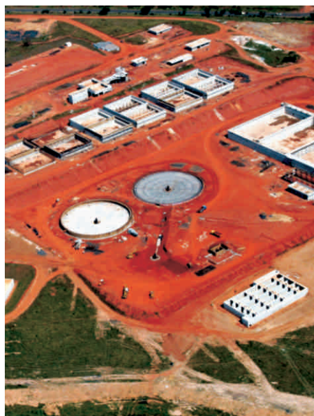
ETE de S. J. Rio Preto - Vista panorâmica
