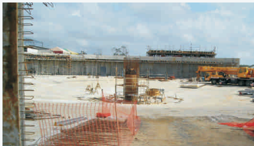
Canteiro da obra
